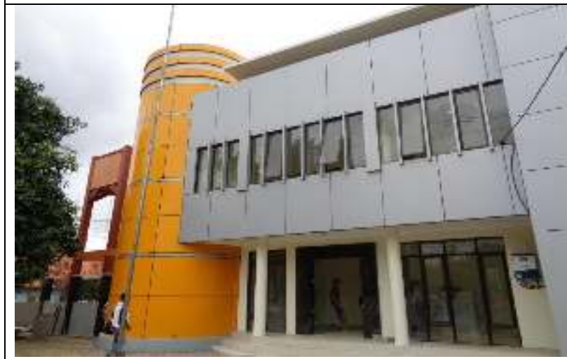
Pembangunan Gedung Unit Metrologi Legal
