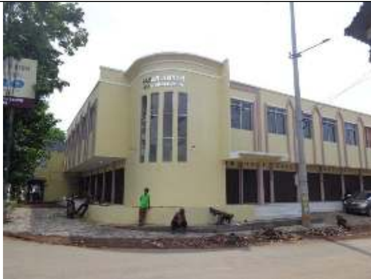
Pembangunan Pasar Anyar
